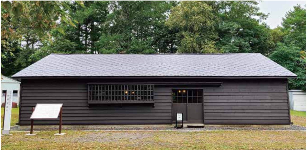
改修工事を終え開館した旧塘路駅通所(令和5年9月)
