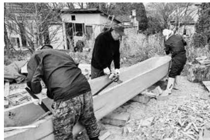
丸木舟製作中の状況
